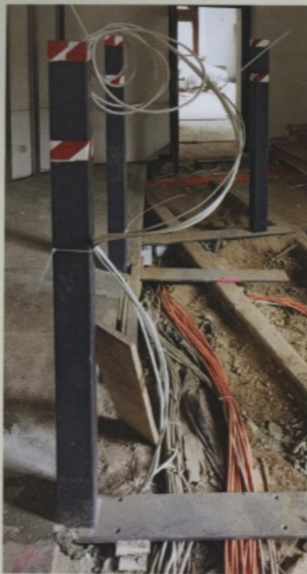
Stabile Unterkonstruktion. Zur Beurteilung der Einspannsituation bzw. zur Bemessung der Grundprofile und Wandständer (Stahlbauhohlprofile MSH 100 x 5) wurde die bestehende Decke geöffnet.
