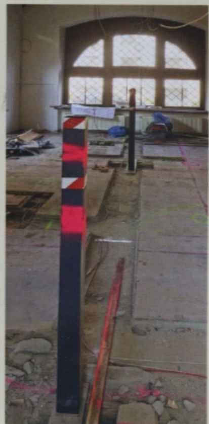
Ausrichtung der Unterkonstruktion. Für die Trennwände im Bürgerbüro wurde vom Ingenieurbüro Werner Kirsch aus Dresden ein Standsicherheitsnachweis erbracht.
