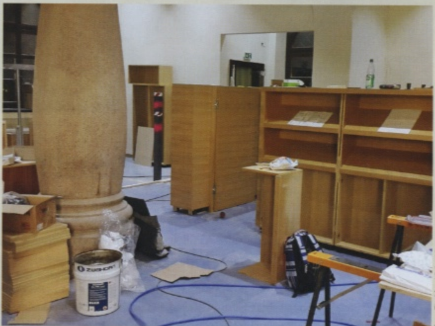
Raumgestaltung mit Holzelementen. Mit dem Innenausbau beauftragt wurde die Bau- und Möbeltischlerei Schmidt aus dem thüringischen Orlersleben. In der Mitte und am rechten Rand sieht man noch die roten Ringe der Hohlprofile, die im Boden verankert die Wandscheiben stabilisieren werden.
