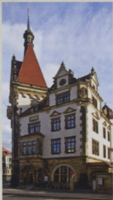
Eingemeindet nach Dresden. Das im Jahr 1894 im Stil der Neorenaissance errichtete Plauener Rathaus steht natürlich inzwischen unter Denkmalschutz.
